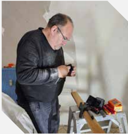
Ein wichtiges Standbein, das während der Corona-Pandemie das Überleben von UBS Quality Sound gesichert hat: die Gebäudeelektrik.
